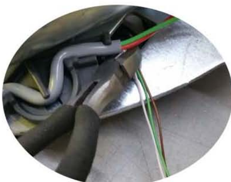
die nicht benötigten dünnen Kabel abtrennen
