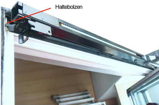
Der Ausstellarm liegt jetzt frei und kann demontiert werden
